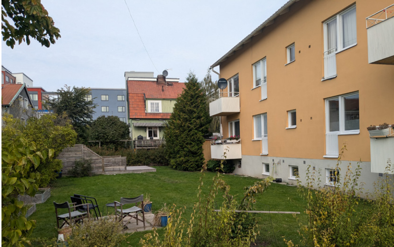
Remonten 4, med befintlig bostadsgård och bostadshus uppfört i två våningar med inredd vind. I bilden ovan syns källarplan med källarfönster. Ny detaljplan föreslås justeras så att inredning av befintligt källarplan blir möjligt genom tillskapande av större fönster (möjligt genom lokal sänkning av marknivå).
