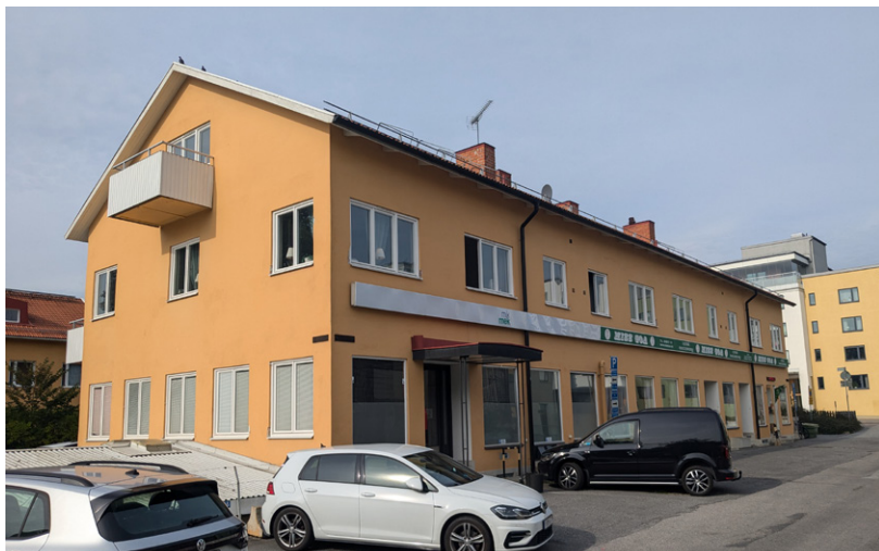
Remonten 3, med befintligt bostadshus uppfört i två våningar med delvis inredd vind. I bilden ovan syns stora fönster partier mot gata.
